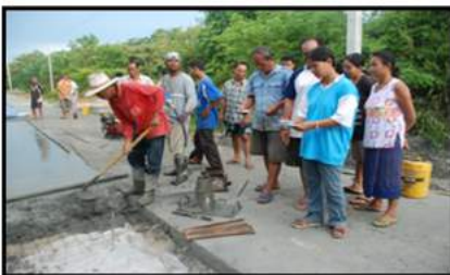
ตรวจสอบขั้นตอนการก่อสร้างถนนคอนกรีตเสริมเหล็ก
